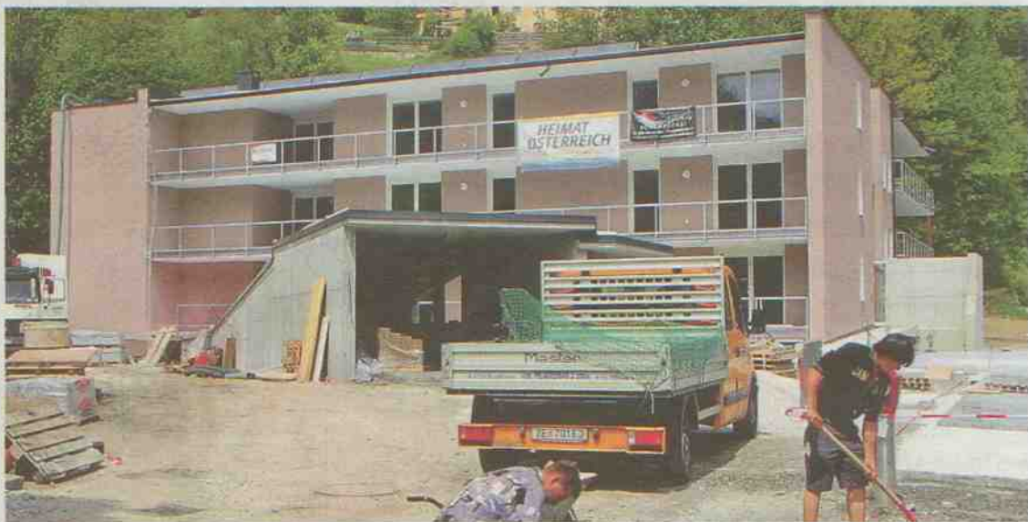
Noch wird eifrig gebaut: Aber bereits mit Juli werden die Wohnungen bezugsfertig sein.
